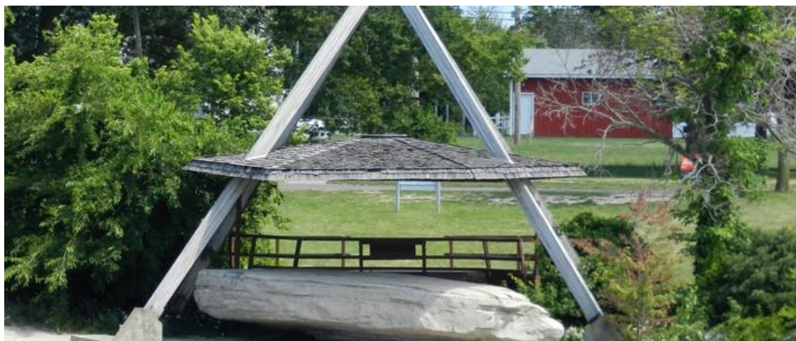
Foto 72. Ejemplo de cubierta para petroglifo, soportada por estructura triangular y placa de concreto.
