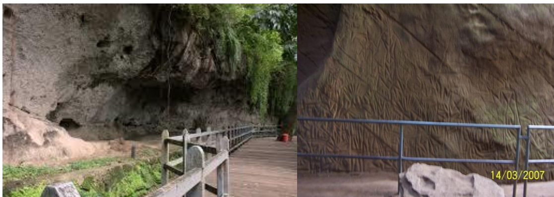
Fotos 70 y 71. Cerramiento para protección de petroglifos en madera tratada (izquierda) y en tubos metálicos (derecha).
